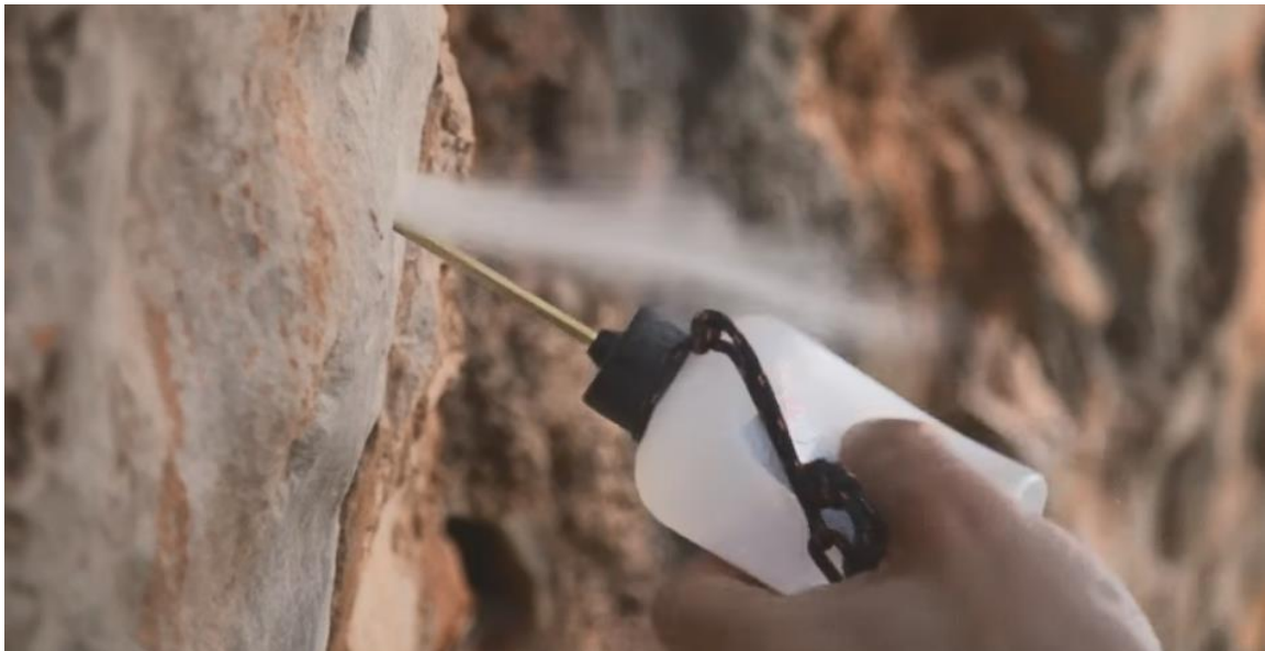
Hình 4: Xịt bột đá ra khỏi lỗ khoan
