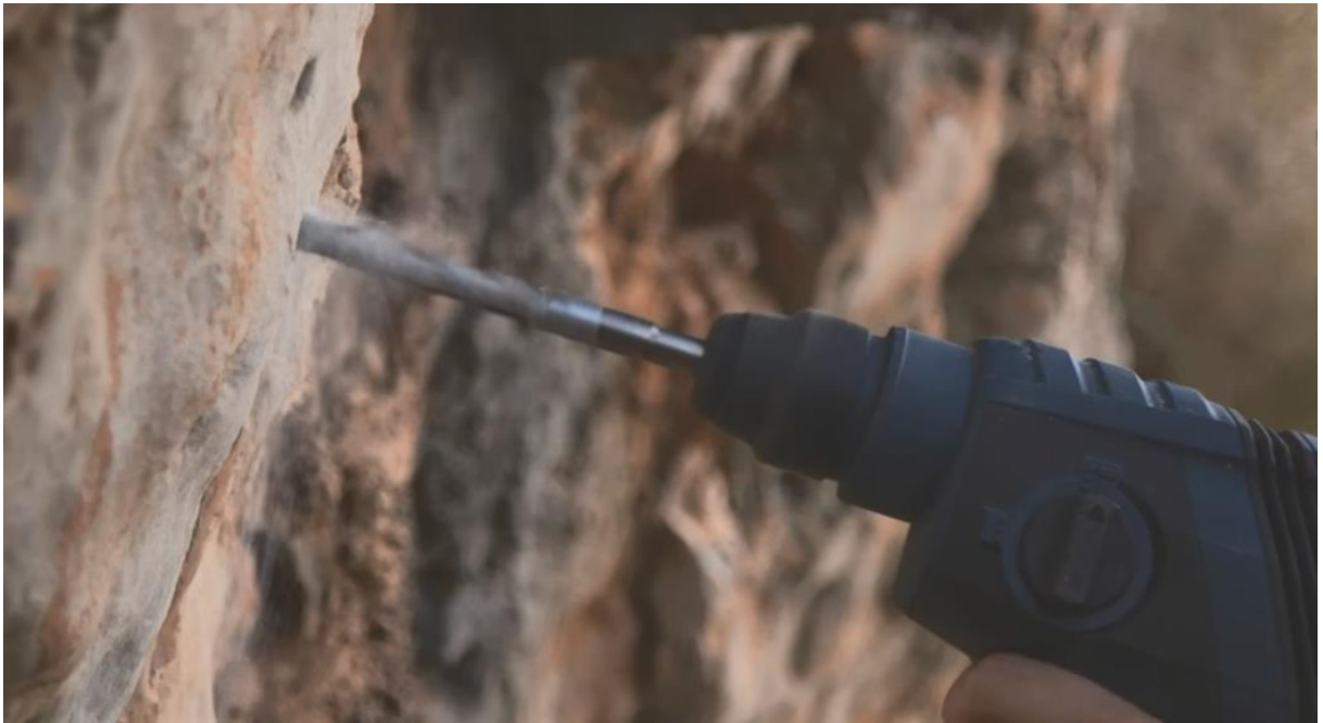
Hình 2: Sử dụng khoan để tạo lỗ bắt điểm neo
